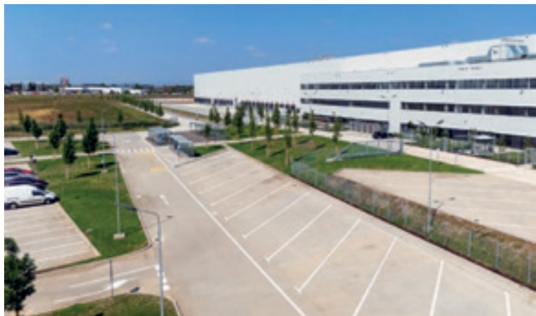
CTPark Ploiesti, fot. CTP
